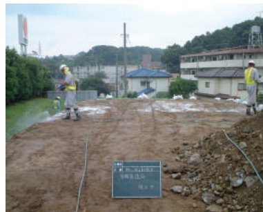
工事用道路(非通行部)
