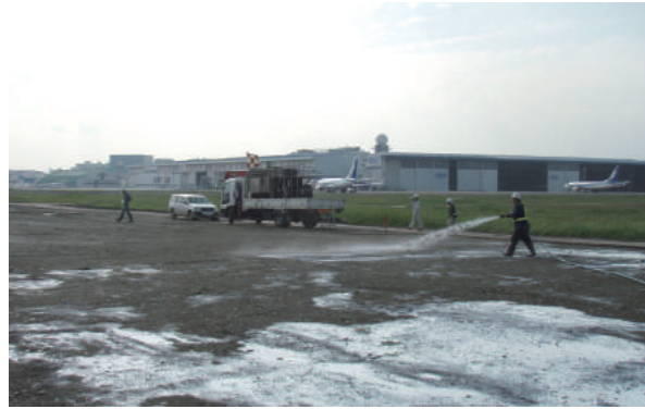
ハイドロシーダーによる施工状況
