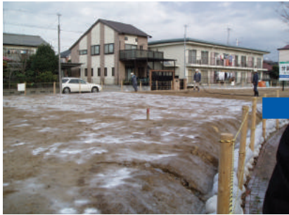
施工直後の状態
